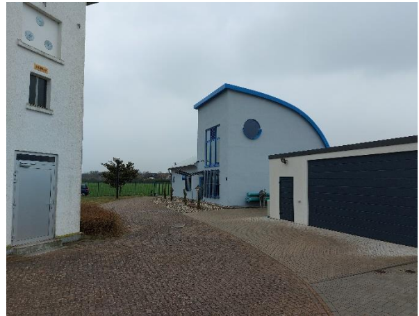
Abbildung 6: Gebäude und gepflasterte Zuwegung
