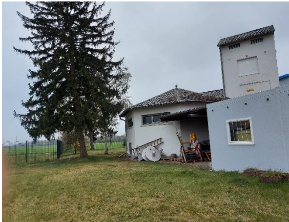
Abbildung 5: Gebäude des Wasserwerks und Fichte mit Brutnachweis des Turmfalken
