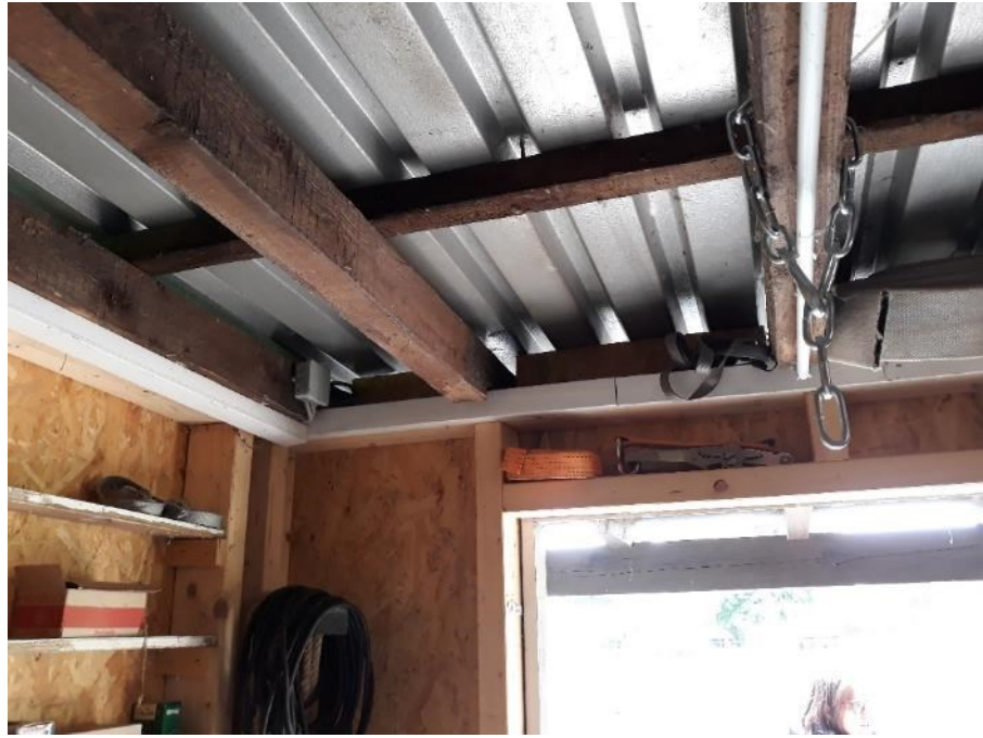
Foto 22: Der Schuppen ist in Leichtbauweise aus Bretten und Balken ge- baut.
