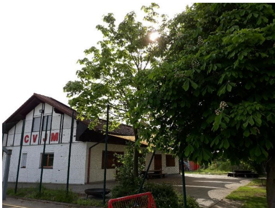
Foto 6: Blick von Norden nach Süden auf die Nordseite des Bestandsgebäudes.
