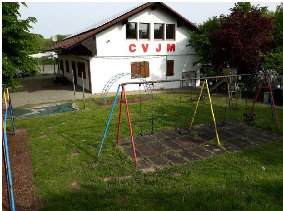
Foto 9: Blick von Süden nach Norden auf die Südseite des Bestandsgebäudes. Der Spielplatz im Vor- dergrund, der Erdhügel (Standort des Fotogra- fen) und die Bäume am linken Bildrand werden für den Anbau an das Bestandsgebäude ent- fernt.
