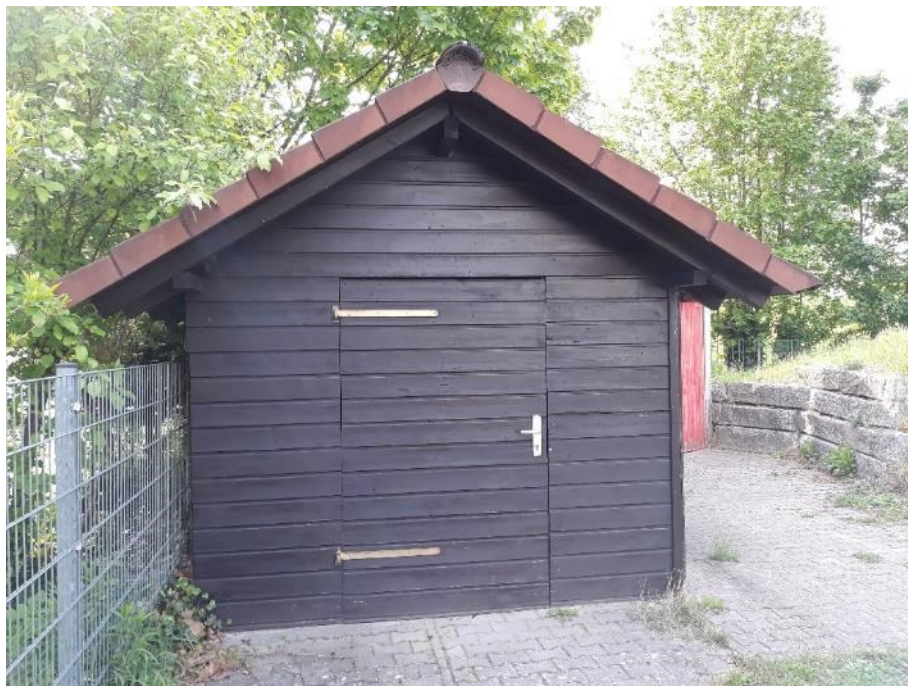
Foto 14: Der Schuppen an der südöstlichen Ecke des Gebiets, der abgerissen werden soll.
